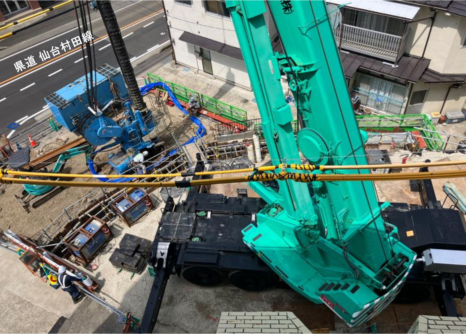
鋼矢板の設置状況写真
