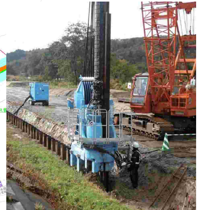
出典：硬質地盤クリア工法 鋼矢板設置状況（土留め）
