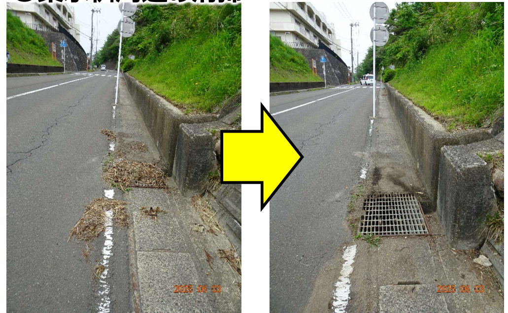
○集水桝周辺の清掃
