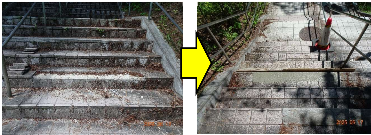
○階段踏面破損（モルタルによる補修）
