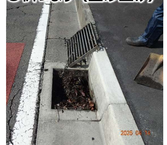
○桝づまり（土砂上げ）
