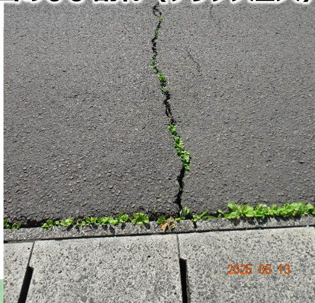
○路面のひび割れ（クラック注入）
