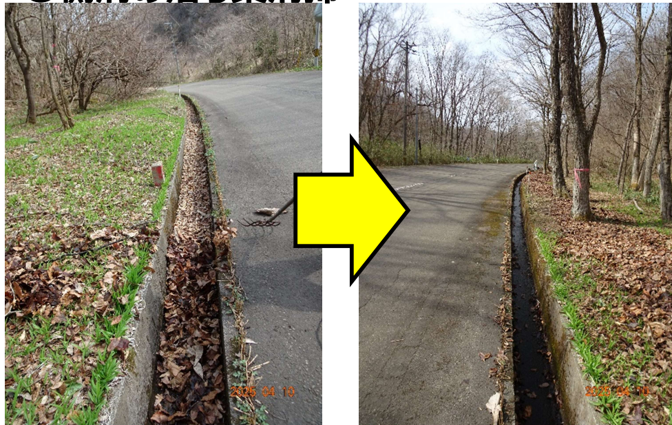
○側溝の落ち葉清掃
