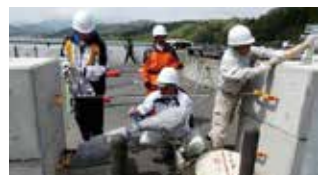
▲コンクリートブロックへの固定
