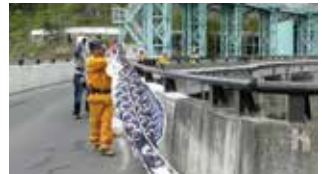
▲安全を確保した堤体上での作業
