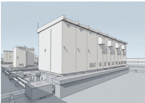
設備機器の浸水対策
