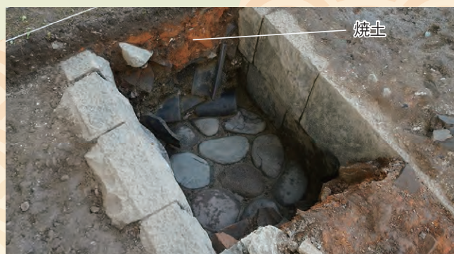
雨落ち溝の構造
