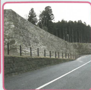
本丸北西石垣の復旧状況 (平成27年2月)
