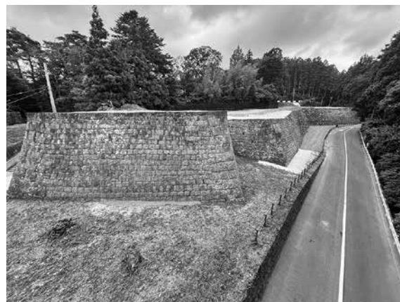
復旧完了後の仙台北城跡本丸北西石垣
