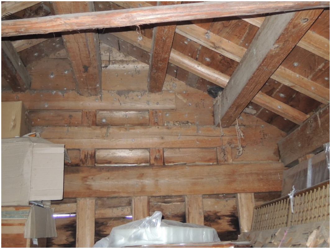
横田家住宅板倉（内部（小屋組み部分））
