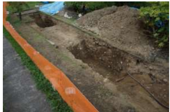
第3次2区 水路跡（堀跡）検出状況（南東から）
