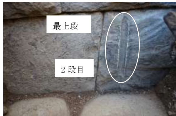
第11図 石組側溝 電気工具による痕跡(白枠内)
