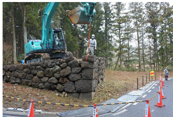
(国指定) 仙台城跡 中門南側石垣の応急措置状況
