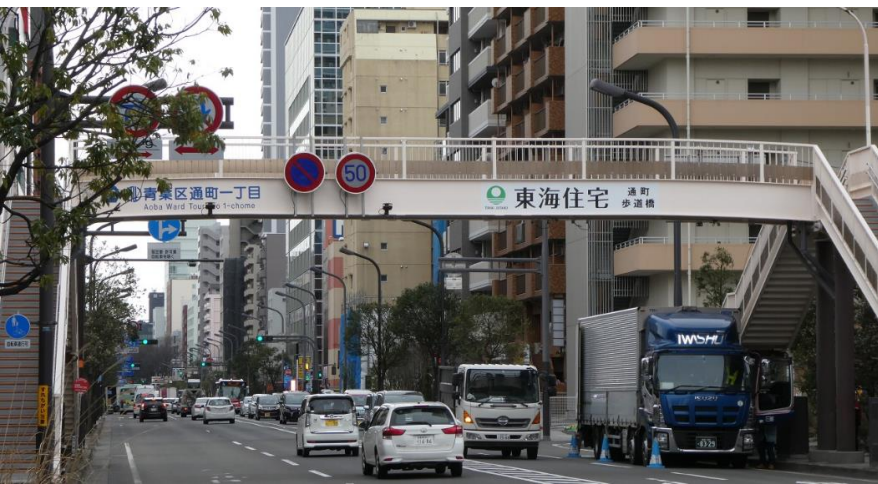
東海住宅通町歩道橋
