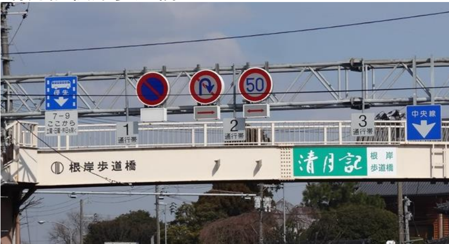
清月記根岸歩道橋
