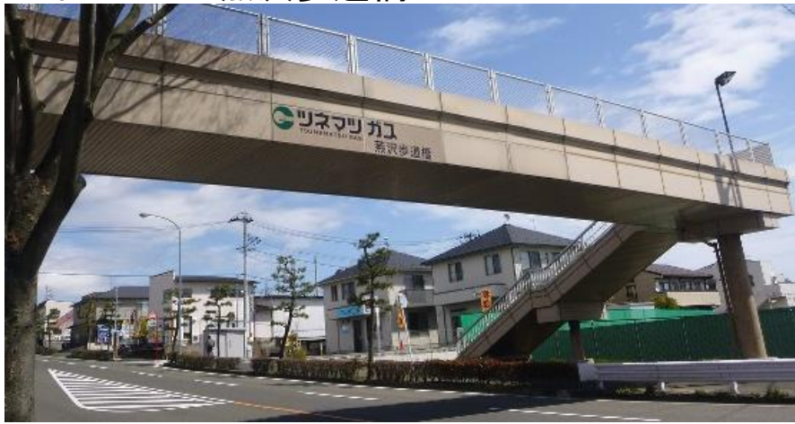
ツネマツガス燕沢歩道橋
