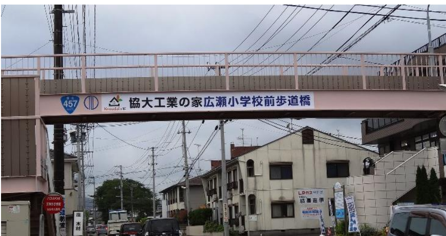
協大工業の家広瀬小学校前歩道橋
