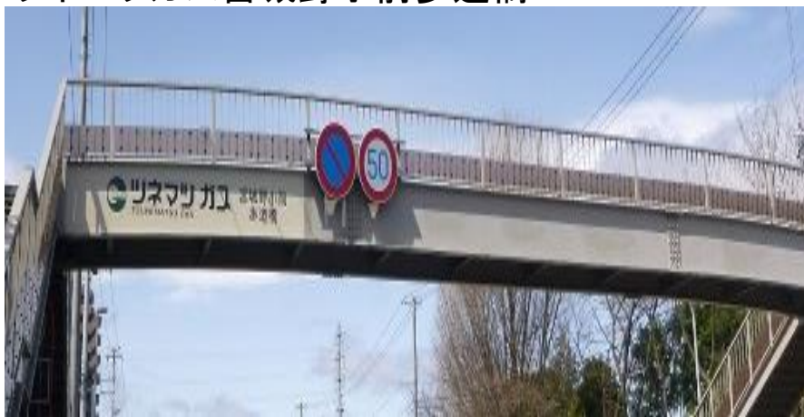
ツネマツガス宮城野小前歩道橋
