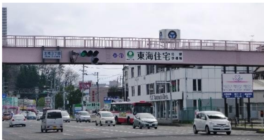
東海住宅北根歩道橋
