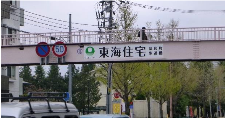
東海住宅昭和町歩道橋
