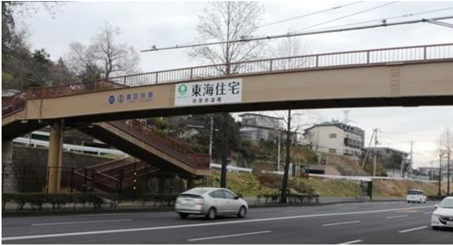
東海住宅向原歩道橋
