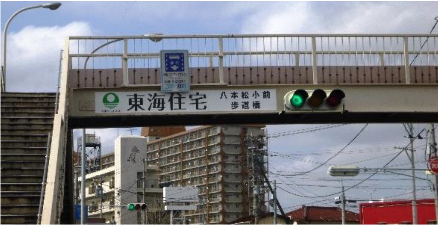
東海住宅八本松小前歩道橋
