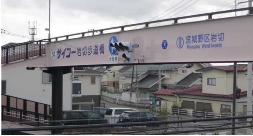
サイコー岩切歩道橋
