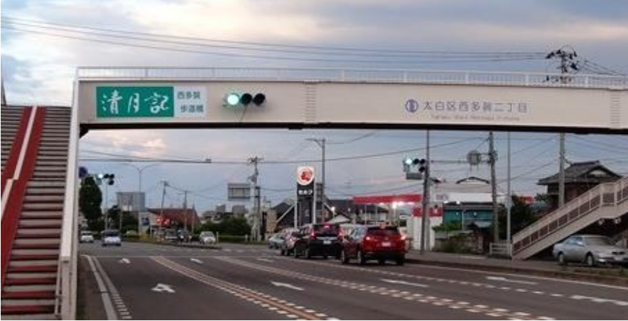
清月記西多賀歩道橋
