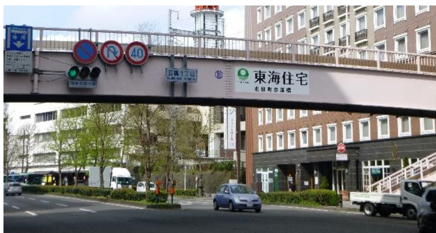
東海住宅北目町歩道橋
