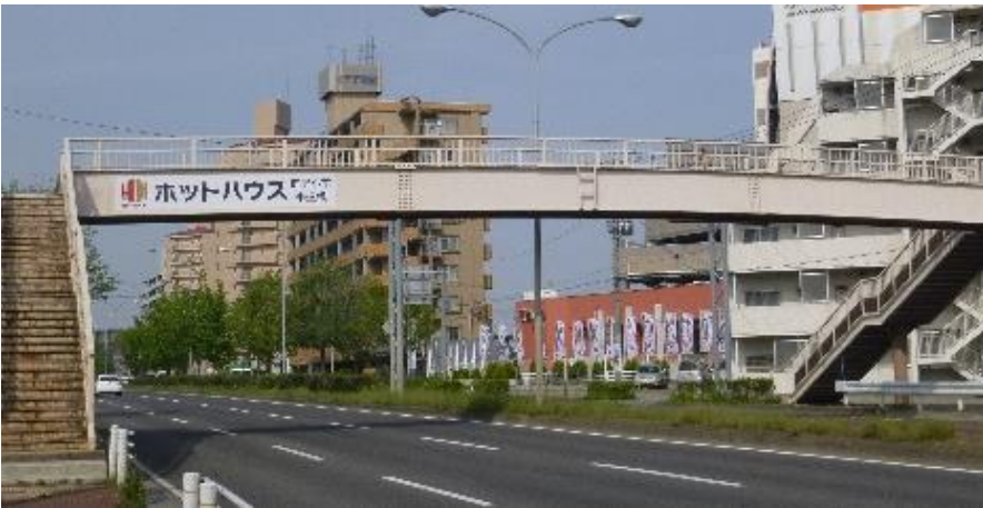
ホットハウス鹿野小前歩道橋
