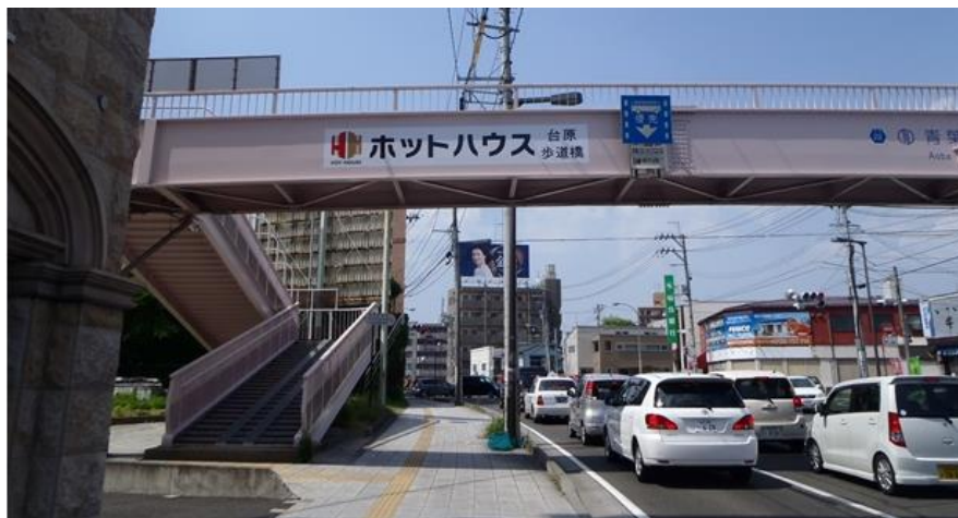
ホットハウス台原歩道橋
