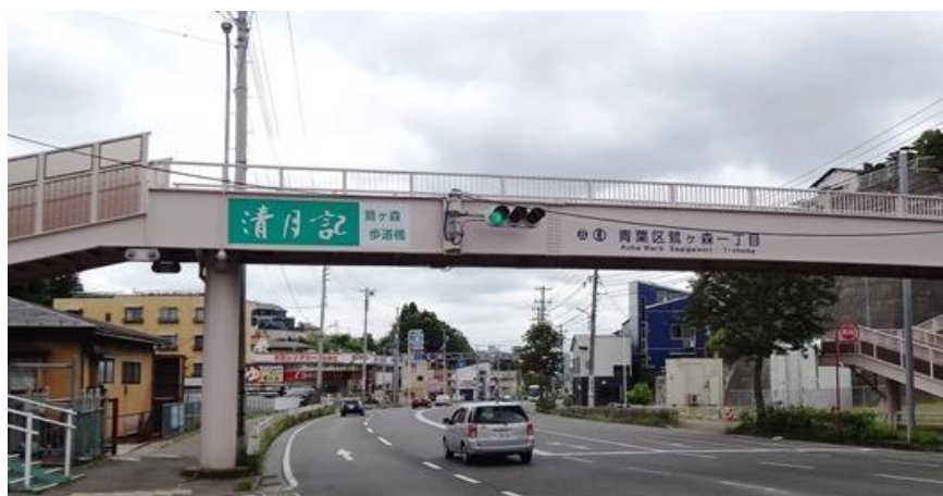
清月記鷺ヶ森歩道橋
