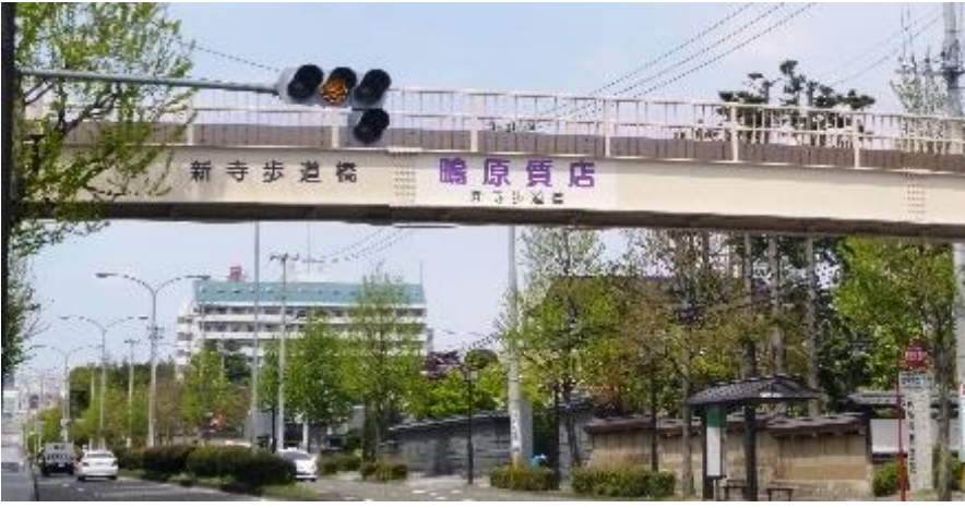
鳴原質店新寺歩道橋
