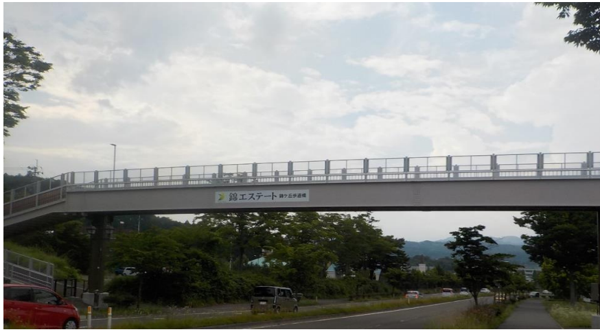
錦エステート錦ヶ丘歩道橋
