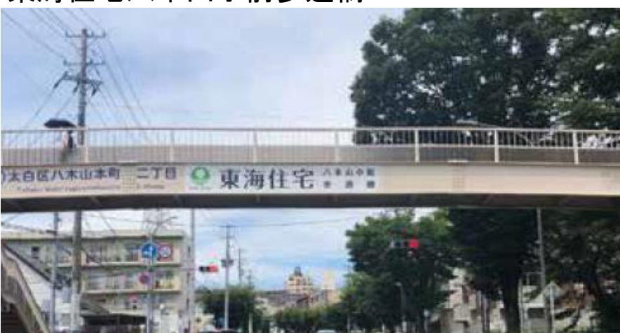
東海住宅八木山小前歩道橋
