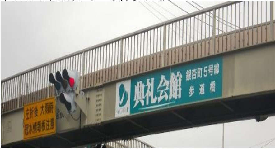
典礼会館銀杏町5号線歩道橋
