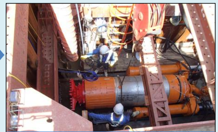
掘進機 設置完了
