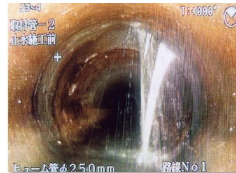
写真2 雨天時浸入水のカメラ調査
