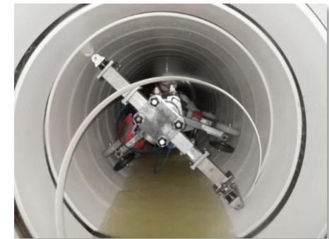
写真3 管更生工法による管路施設の改築
