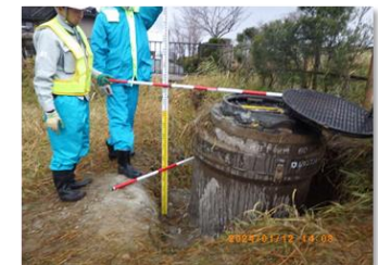
写真5 職員派遣による技術協力 (令和6年能登半島地震*)
