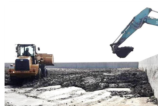
写真9 発生した未焼却汚泥
