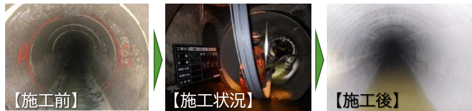
写真5 管更生工法による耐震化
