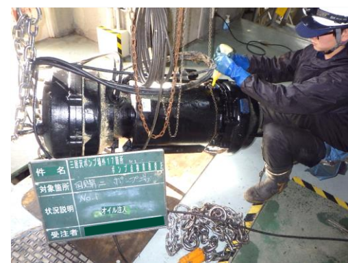
写真4 ポンプの定期点検
