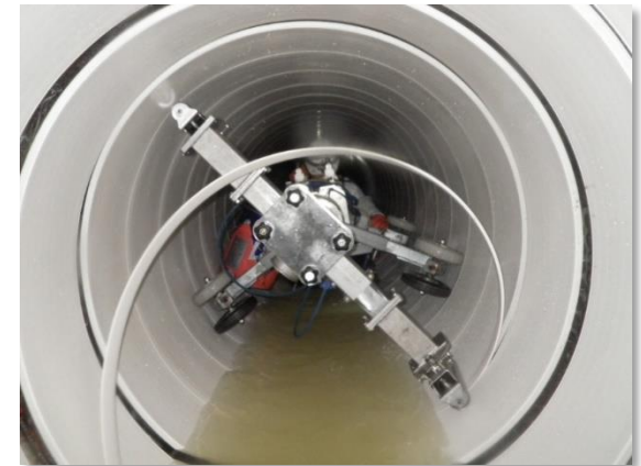
写真14 管更生工法による管路施設の改築
