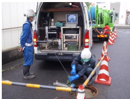
写真3 下水道管のテレビカメラ調査
