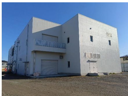
写真6 諏訪町ポンプ場 (分流汚水施設)
