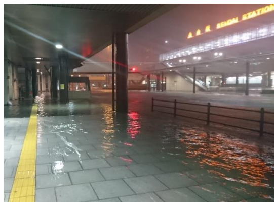
写真2 令和元年東日本台風により冠水した仙台駅西口
