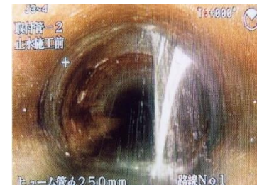
写真7 雨天時浸入水のカメラ調査
