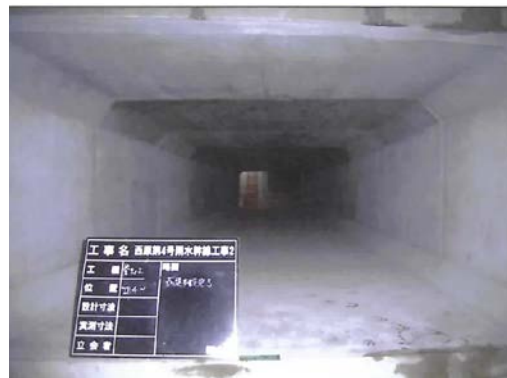
平成 28 年 10 月 西原 4 号雨水幹線工事
