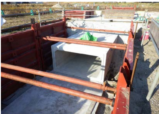
平成 27 年 12 月 西原第 4 号雨水幹線工事
