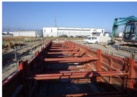
平成 27 年 12 月 西原第 4 号雨水幹線工事
