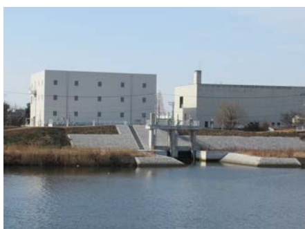
平成 31 年 3 月 鶴巻ポンプ場工事
