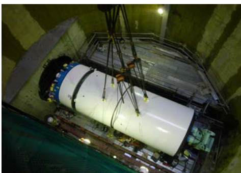
平成 28 年 11 月 シールドマシン投入状況 (幹線工事 2)
