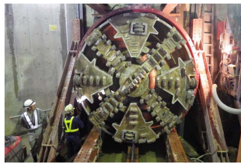
平成 29 年 6 月 シールドマシン到達状況 (幹線工事 1)
