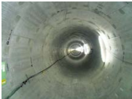
平成 30 年 3 月 内面仕上状況 (幹線工事 1)
