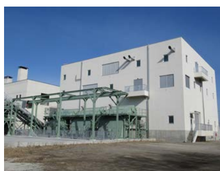
平成 31 年 3 月 鶴巻ポンプ場工事
