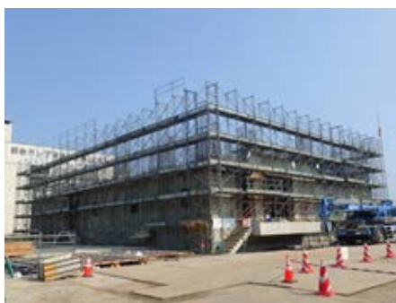
平成 29 年 6 月 鶴巻ポンプ場工事
