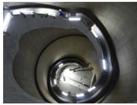
平成 31 年 3 月 No.3 人孔内部 (幹線工事 1)
