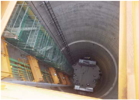
平成 27 年 9 月 No.3 立坑 (幹線工事 1)
