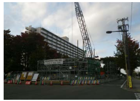
平成 27 年 10 月 No.2 立坑 (幹線工事 2)
