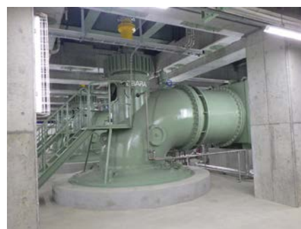
平成 31 年 3 月 鶴巻ポンプ場工事（ポンプ設備）
