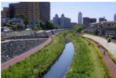
▲ 河川敷へのスロープや水辺の散策路(埼玉県川口市)
