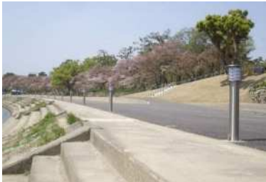
▲ 安全に歩くための足元を照らす照明 (愛知県岡崎市)
