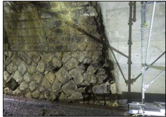
側壁の損傷【健全度：Ⅲ】
