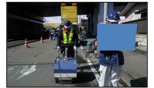
二次調査 ハンディ型地中レーダによる位置特定状況
