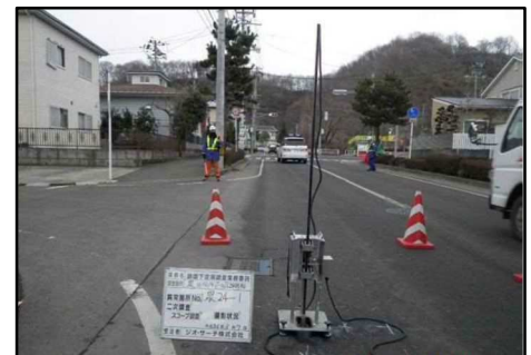
二次調査 スコープカメラ撮影状況
