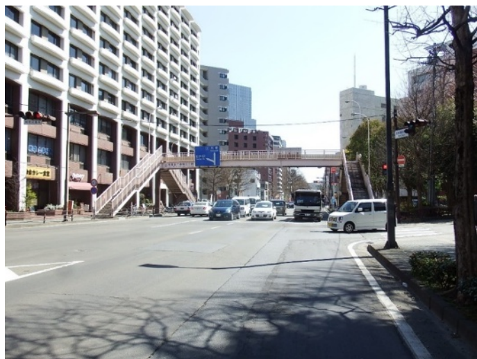
片平丁小学校前歩道橋
