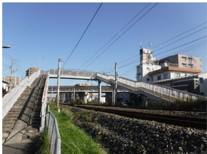
高瀬町歩道橋
