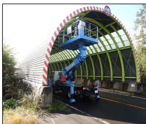
シェッド・シェルター点検状況
