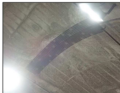
はく落防止対策工
