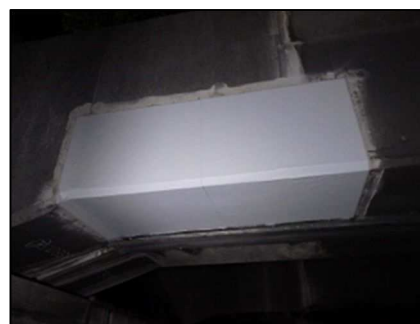
断面修復工、はく落防止対策工
