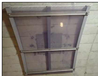
アーチパネル工
