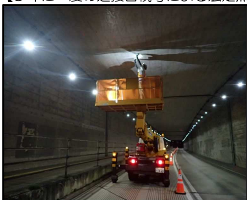
トンネル点検状況
