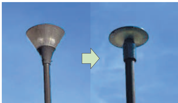
公園照明灯の 水銀灯から LED 灯への更新
