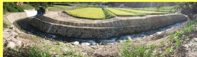
周辺環境に配慮し、空積みにより整備された護岸 (鰻沢川)
