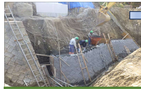
護岸ブロック積の作業状況です。
