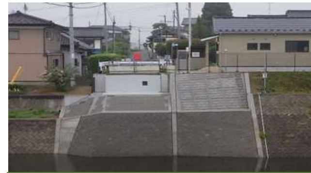
A1橋台(町頭側)完成
