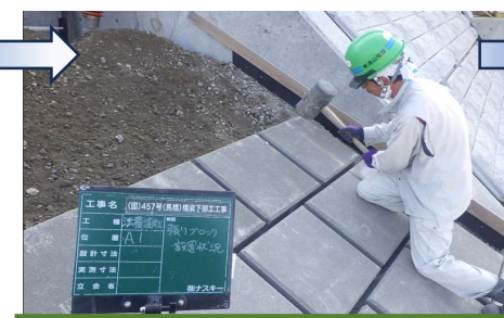
ブロック張りの作業状況です。
