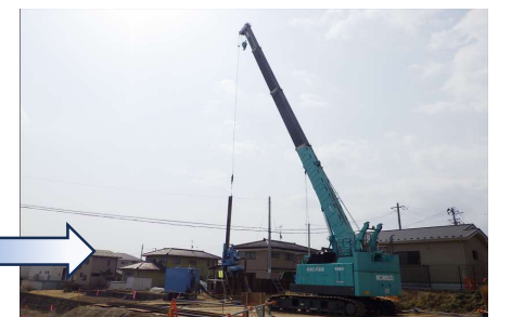
土留鋼矢板撤去状況です。
