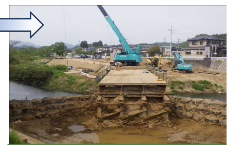
仮橋の撤去状況です。
