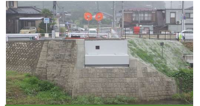
A2橋台(古屋敷側)完成
