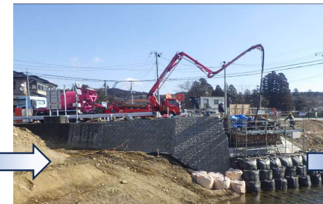
コンクリートの打設状況です。
