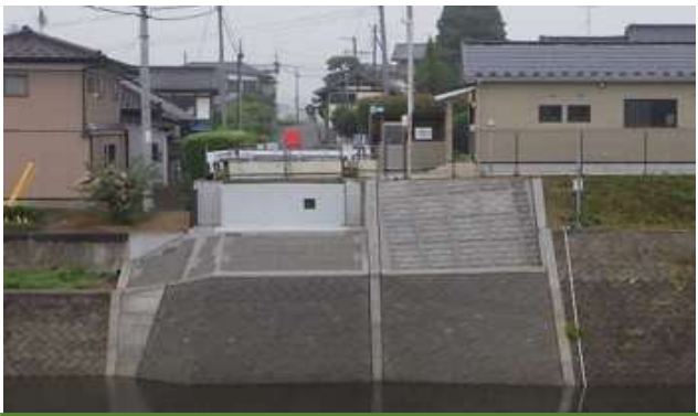
A1橋台（町頭側）完成
