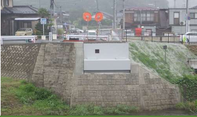
A2橋台（古屋敷側）完成
