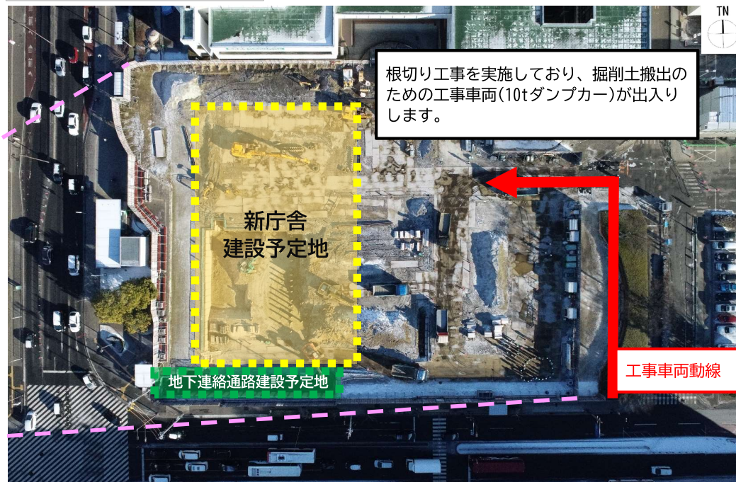
上空写真(R7.2月下旬撮影)
