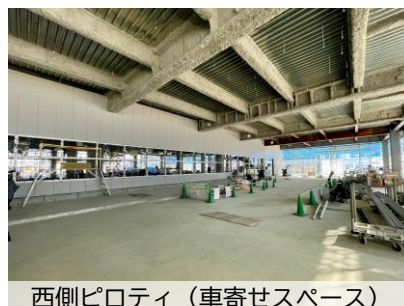
西側ピロティ (車寄せスペース)
