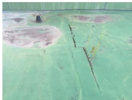
本庁舎屋上防水の状況
