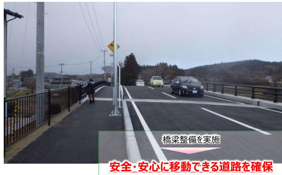
被災橋梁下流側に橋脚の無い橋梁を整備し、被災橋梁の橋脚を撤去することにより、安全・安心を図る
