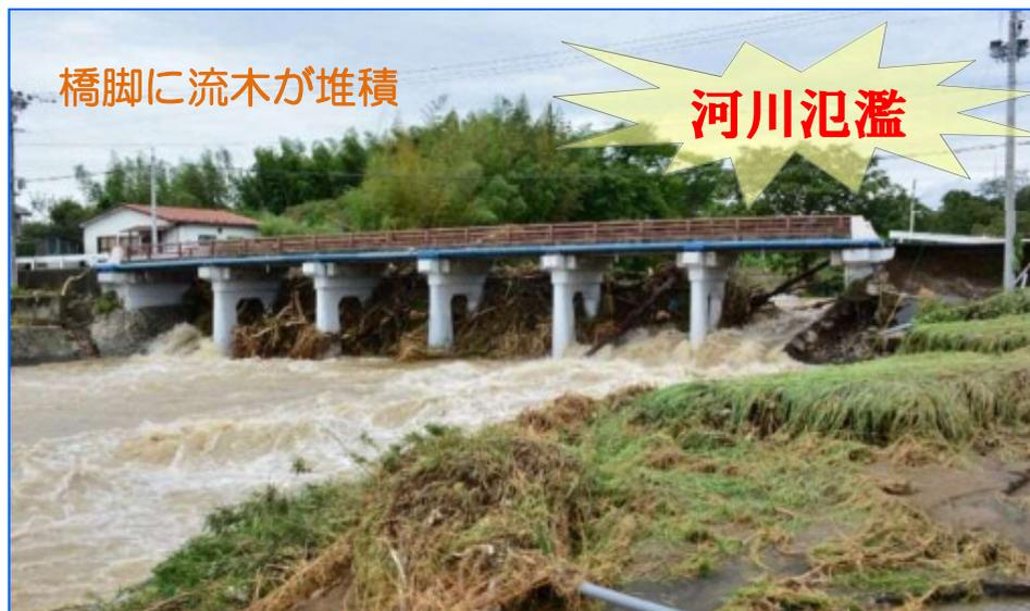
旧基準で設計された橋脚が多い橋梁であり、豪雨時に流木が橋脚に堆積し、河川が氾濫した
