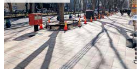
定禅寺通再整備
