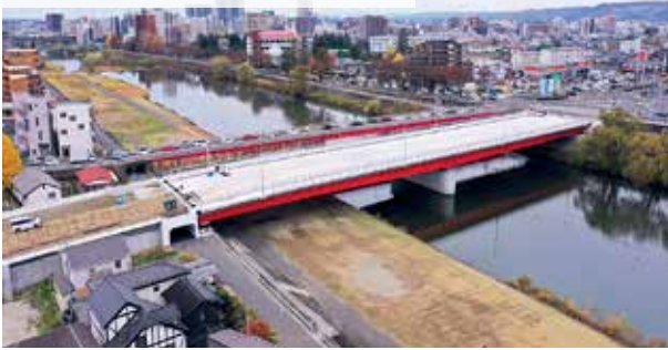
南小泉茂庭線(宮沢橋工区)
