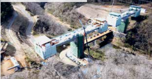
国道286号(南赤石工区)
