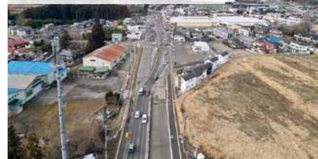
主要地方道泉塩釜線(野村工区)
