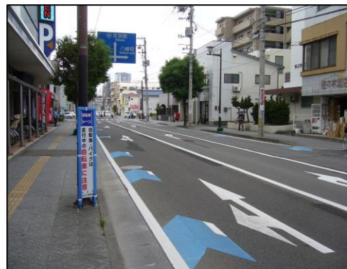
【写真 3-6】単路部の矢羽根型路面表示設置の事例 （市道宮町通線）
