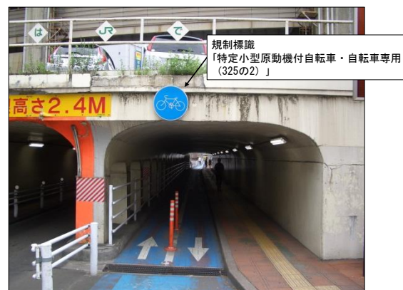
【写真 3-1】青系色の自転車道整備事例 （市道中央一丁目西宮城野線）
