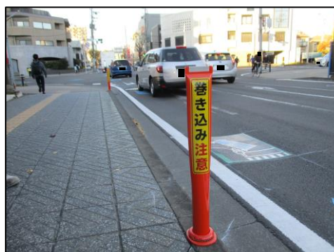
【写真 3-9】ラバーポール・看板等を用いた左折巻き込み事故対策の事例 (市道宮町通線)
