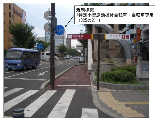
【写真 3-2】青系色以外の自転車道整備事例 （市道宮城野通線）
