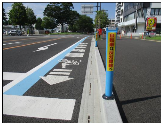
【写真 3-4】ラバーポールを用いた逆走対策の整備事例 （市道卸町大和町（その2）線外1線）
