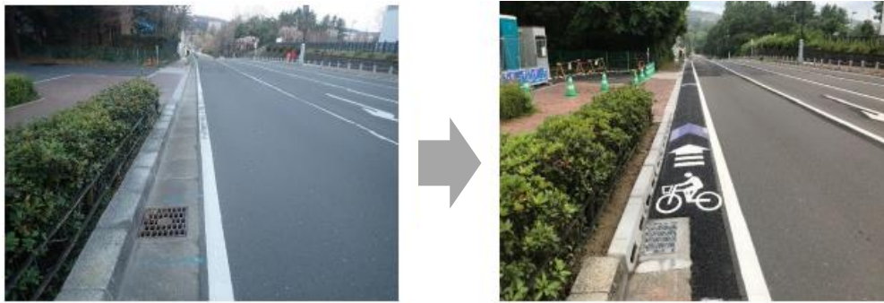
【図 3-2】暗渠型側溝等への改修で自転車通行空間を確保した事例（市道青葉山線）
