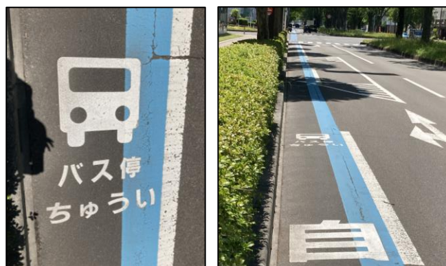
【写真 3-10】「バス停ちゅうい」のピクトグラム設置事例 （市道卸町大和町（その2）線外1線）
