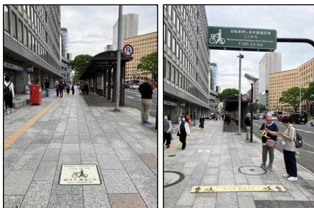
【写真 4-6】歩行者交通量が特に多い路線への 自転車の降車を促す路面表示設置 （国道 286 号のバス停付近）
