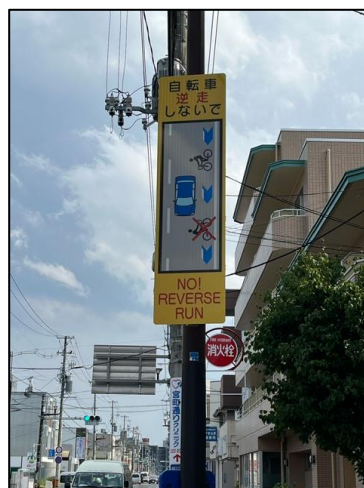
【写真 3-5】看板を用いた逆走対策の整備事例 （市道宮町通線）
