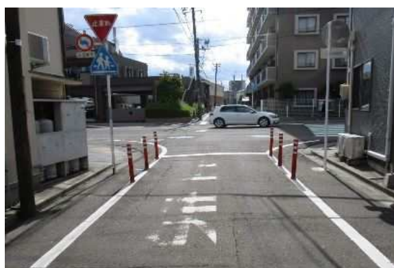
図 4.45 狭さく設置事例 (青葉区宮町5丁目)
