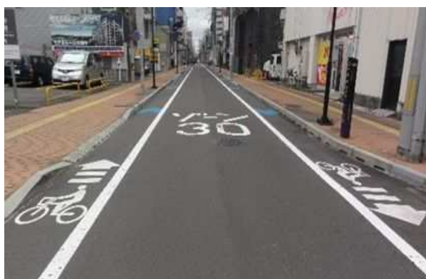
図 4.44 ゾーン30のピクトグラム設置事例 (青葉区大町2丁目)
