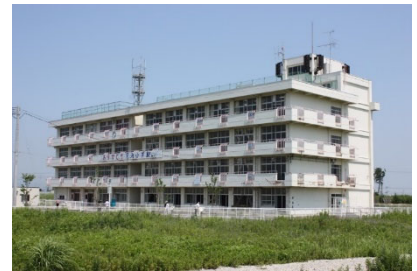
震災遺構 仙台市立荒浜小学校
