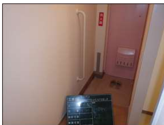
図 4-5 玄関改修 (手摺設置、かまち段差なし)
