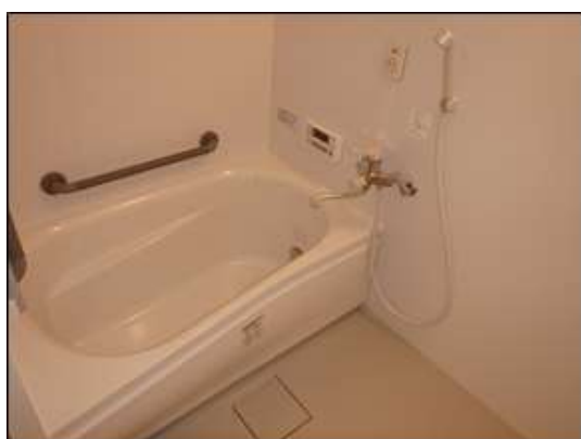
図 4-4 浴室改修 (手摺設置)
