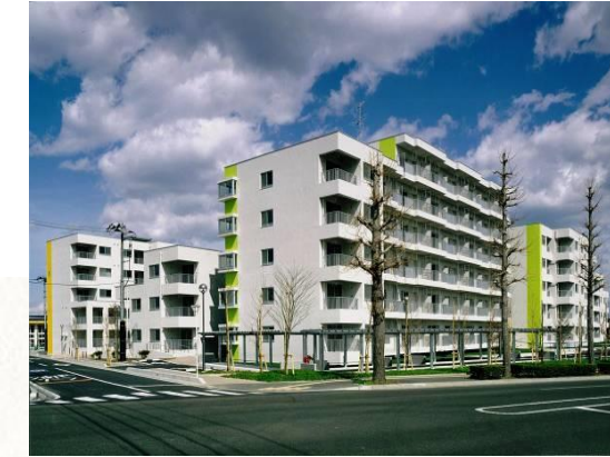
①鶴ヶ谷第一市営住宅（第一工区）
