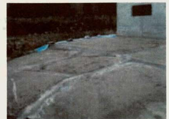
(1) ブルーシートによる宅地亀裂の防護 (2) セメントモルタル充填による亀裂の防護
