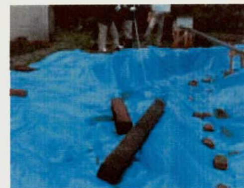
(1) ブルーシートによる宅地亀裂の防護 (2) セメントモルタル充填による亀裂の防護
