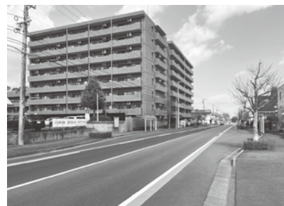
▲自転車通行空間の整備（市道荒巻大和町線）
