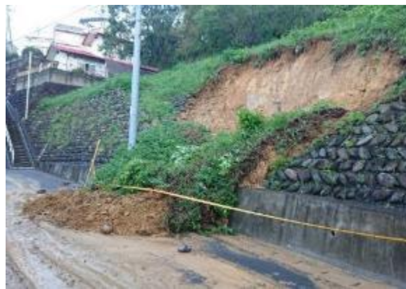
本市における土砂災害（がけ崩れ）の被害 （令和元年東日本台風）
