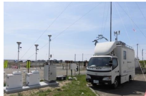
移動測定車による大気調査
