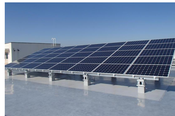
防災型太陽光発電システム
