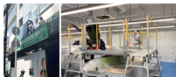
使いながら改修工事の様子
