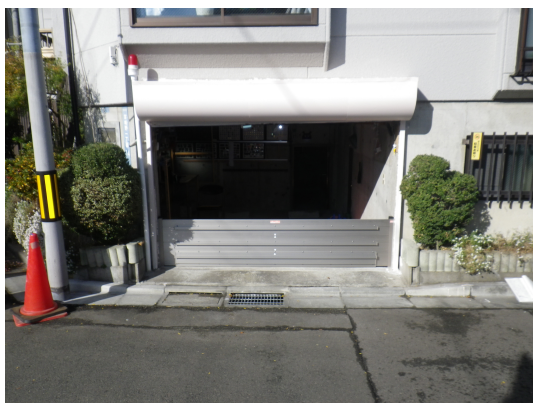
止水板を設置した状態
