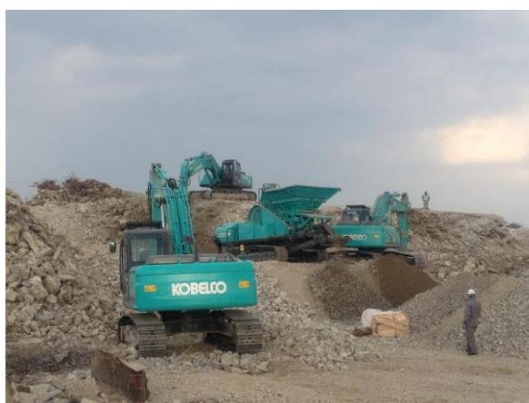
写真 9-2-2 コンクリートがら破碎状況
