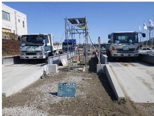
写真 9-1-1 計量器の設置状況
