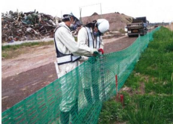
写真 9-1-11 がれき飛散防止ネットの設置状況
