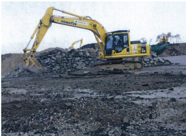
写真 9-3-4 アスファルト舗装撤去状況
