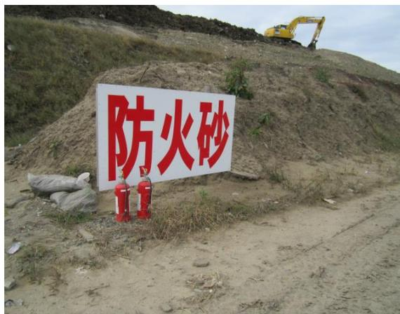
写真 9-1-15 消火土の配置状況
