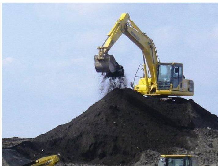
写真9-1-34 バックホウによる選別対象物の空気曝し作業
