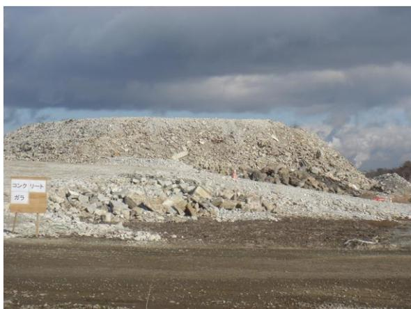
写真 9-2-1 コンクリートがら保管状況
