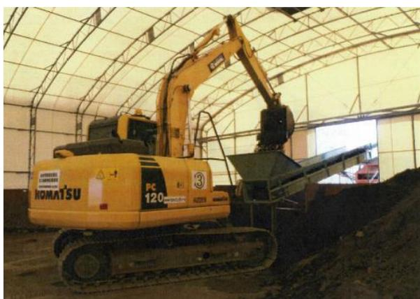
写真 9-1-32 消石灰混合状況
