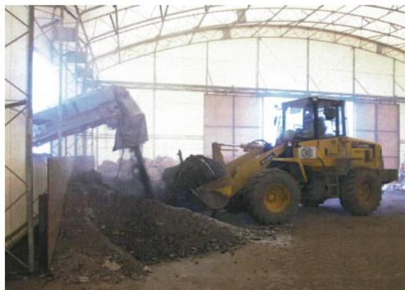
写真 9-1-31 消石灰混合状況
