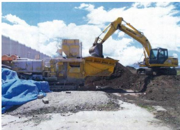
写真 9-1-30 消石灰混合状況（自走式土質改良機）
