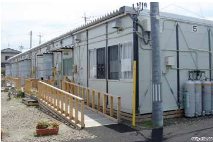
港南西公園仮設住宅
