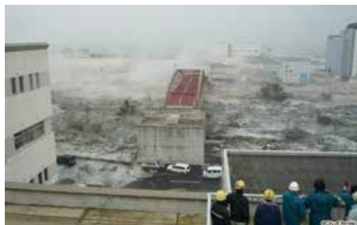
津波被害を受ける南蒲生浄化センター
