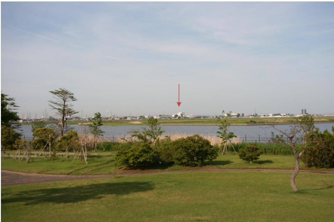
農業園芸センター（工事完了時）
