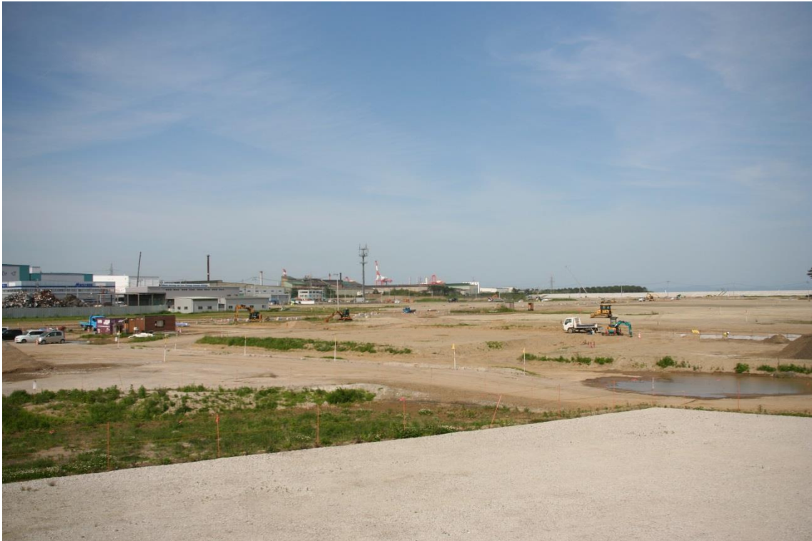
なかの伝承の丘（現状：北東方向）
