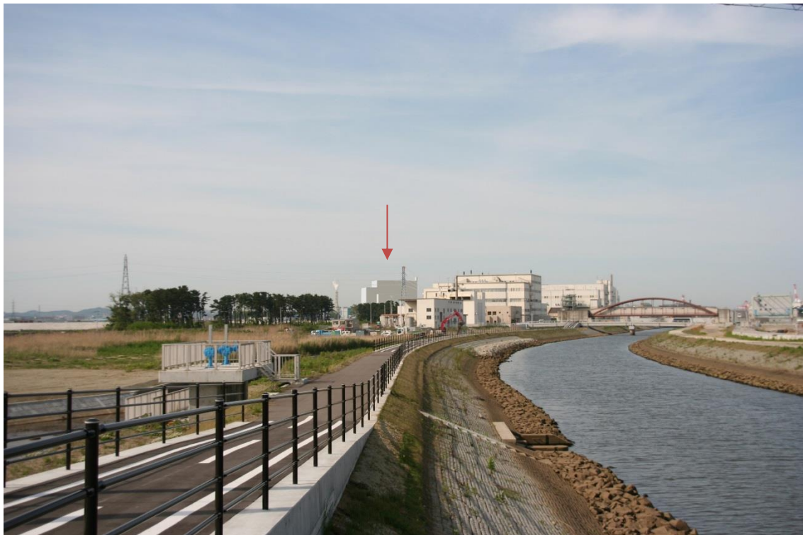
貞山堀（工事完了時）
