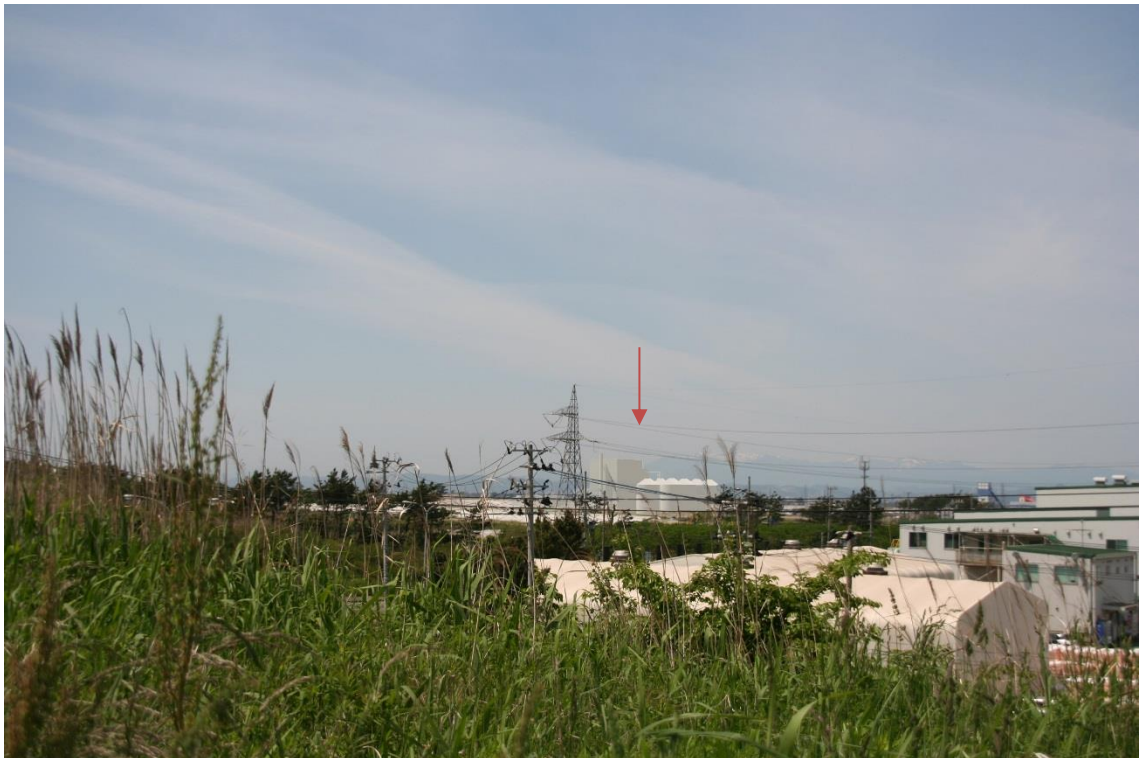
向洋海浜公園（工事完了時）
