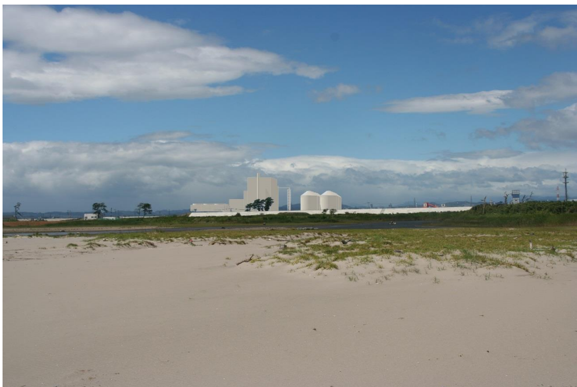
長 浜 (工事完了時)
