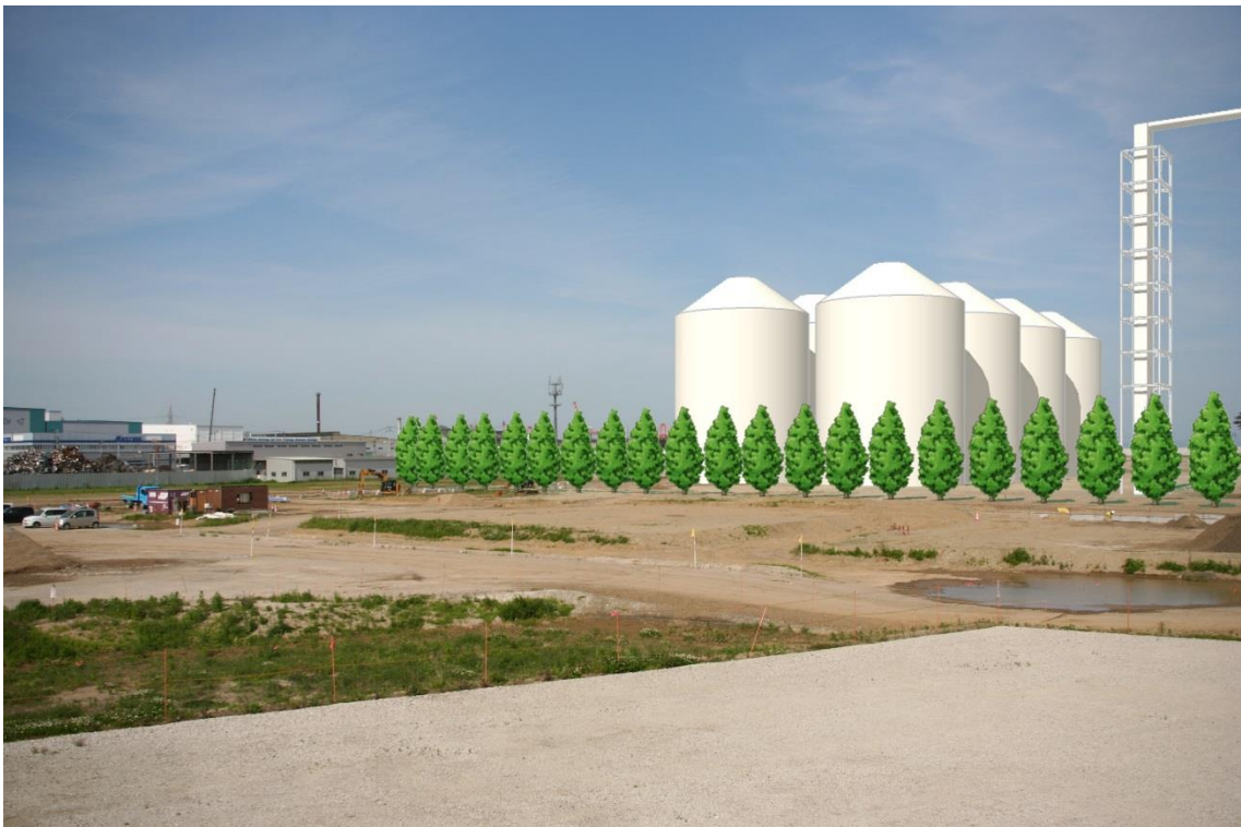
なかの伝承の丘（工事完了時：北東方向）
