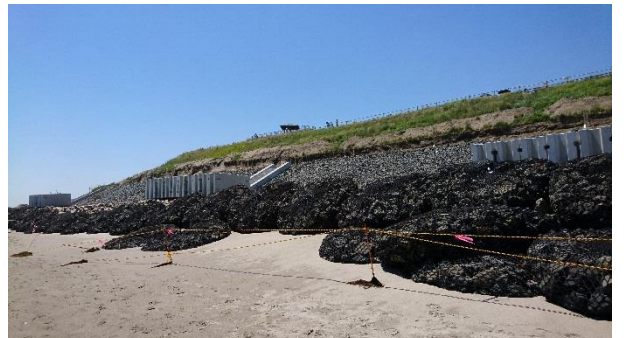
向陽海浜公園の前面海岸から、公園台地及び休憩所を見上げる。
