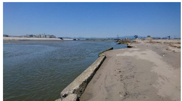
七北田川右岸の中央付近（コンクリート護岸）
