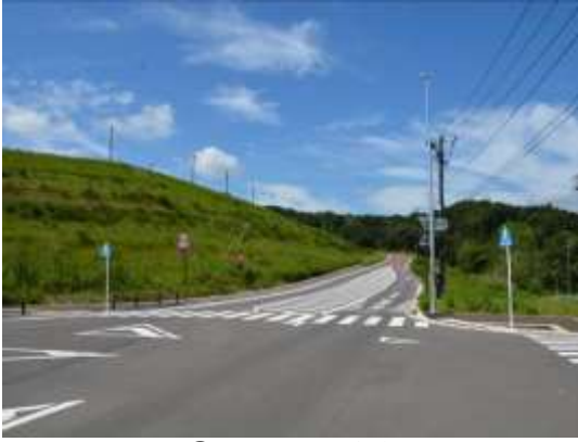
①北側幹線道路
