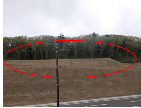
②仮置き土の東側から撮影
